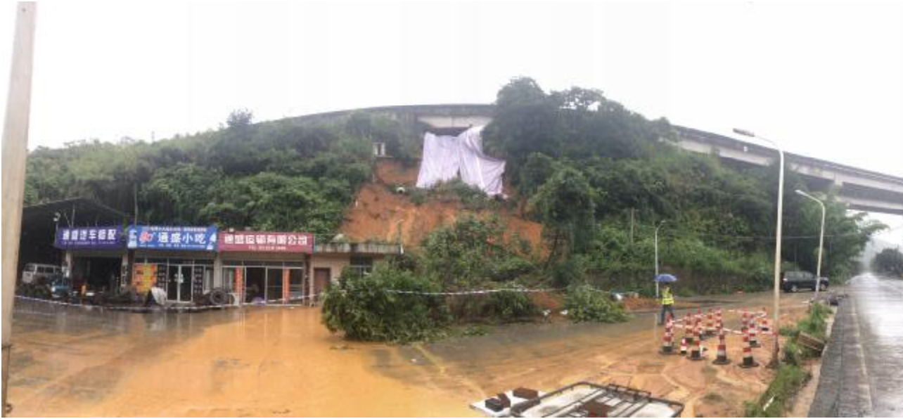
图 1 漳永高速公路芦芝大桥漳州台（BK66+152~BK66+187 段）下边坡塌方
