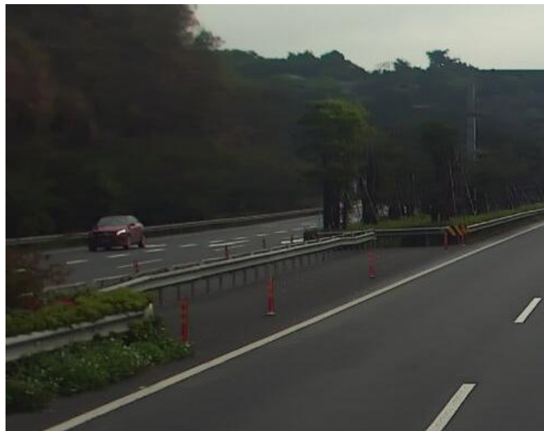
图 1：机场高速二期现有中央开口插拔式护栏
